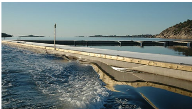
Бетонный причал, армированный базальтовым волокном от шведской компании SF Pontona.
