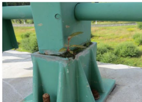
Основные дефекты при эксплуатации композитных материалов и конструкций из них (срок эксплуатации не более 5 лет, с 2012 года).
